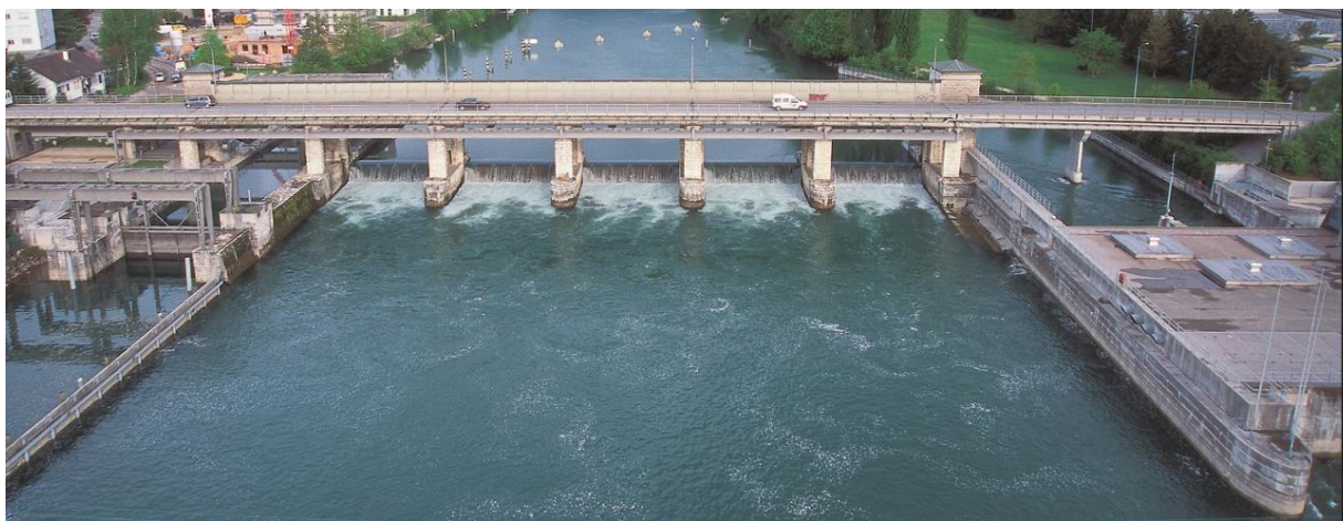
Abbildung: Regulierwehr mit Schiffschleuse links, Regulierwerk in der Mitte, Wasserkraftwerk rechts
