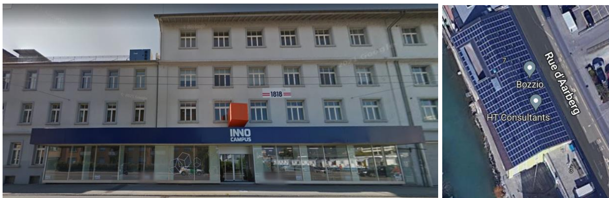
Bilder: Ansichten des FMS-Standorts an der Aarbergstrasse in Biel/Nidau.
