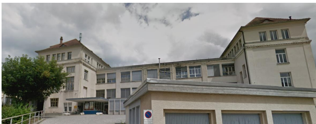
Bild: Aussenansicht der ehemaligen Fabrik der Tavannes Machines.
